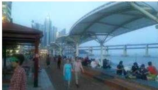
[그림 6] 수변공원에 설치된 지붕 구조물
